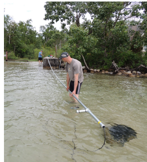
Joel Buzzell installing the sensor conduit.
